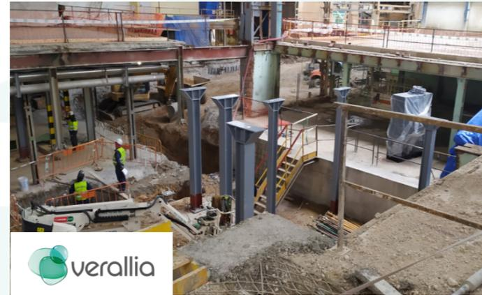
TRESCA ha sido la encargada de gestionar de forma íntegra el proyecto para la implantación de un horno en una planta industrial del sector del vidrio
